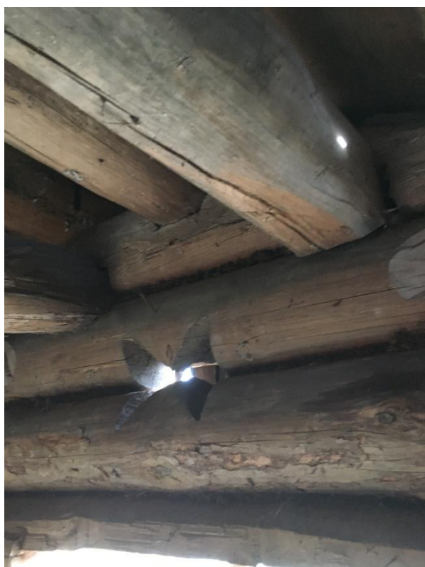
Vackra detaljer (fjäril) i timmerväggen för ventilation. Ett av fönstren på tredje våning som vi tror kan vara från 1700-tal.
