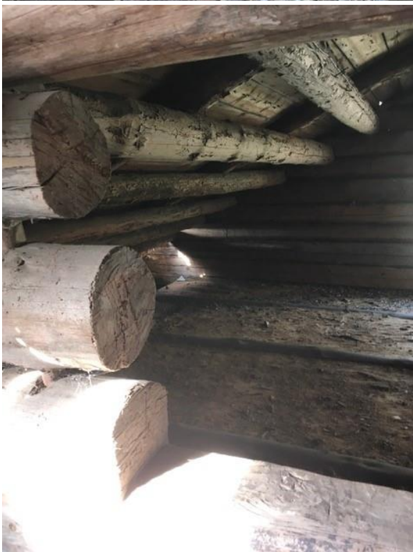
Stora delar av taket är i gott skick när det gäller åsar, rafter och brädor. Taket är delvis öppet i nock och på två ställen nära knutarna men övrigt är det fint.
