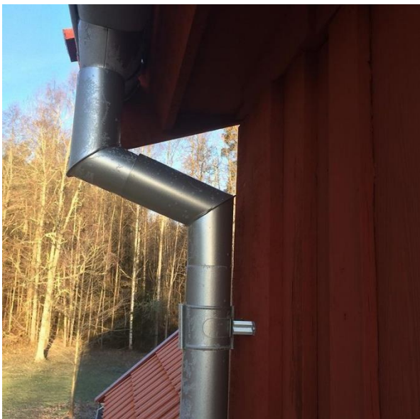
Bildtext: Alugalvade rör och raka knä/böjar på stuprör.
