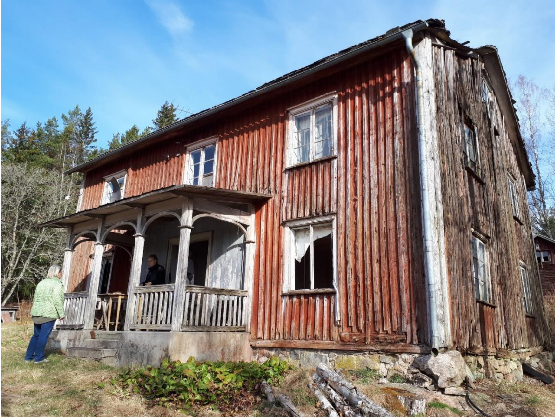
Husets framsida (A-vägg) och D-vägg på höger sida.
