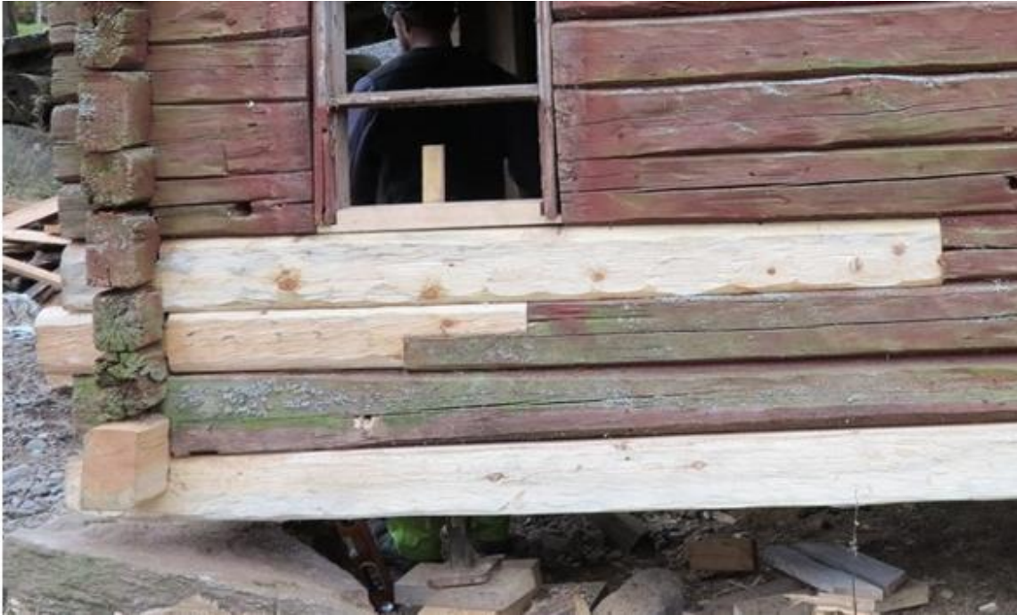
Byte av stockar halvt i halvt från sidan och ovanifrån.
