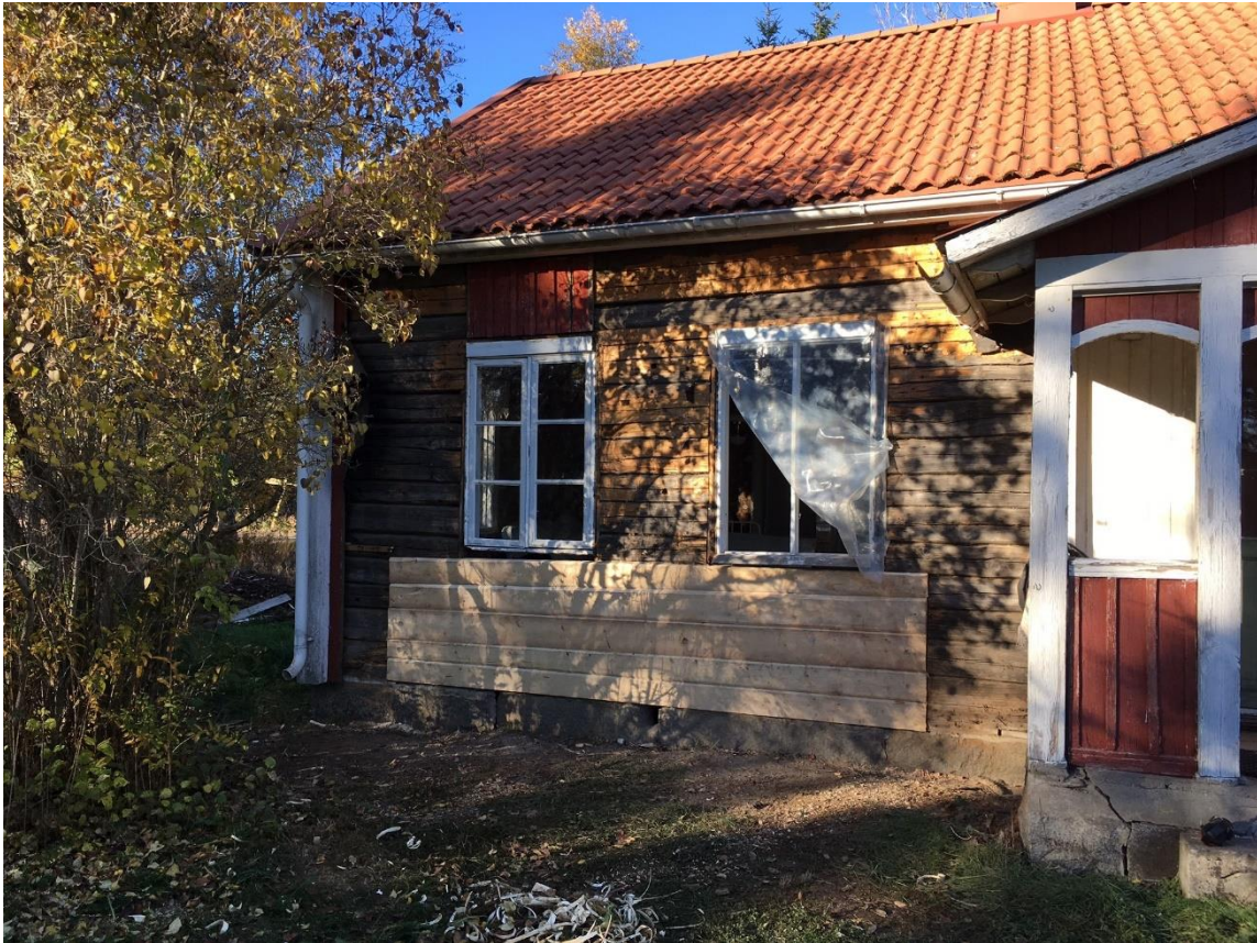
Man byter bara timmer det som är dåligt i konstruktionen. Här är det en halvsulning hela vägen.
