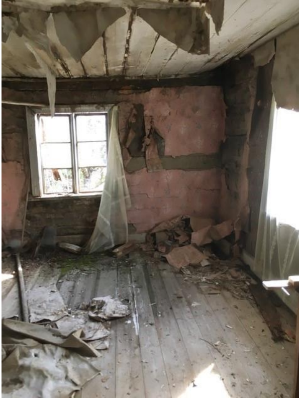
Foto taget mot D-vägg med A-vägg till höger Lerklinate väggar målade i rosa nyans med schablonmålning i blått och rött.
