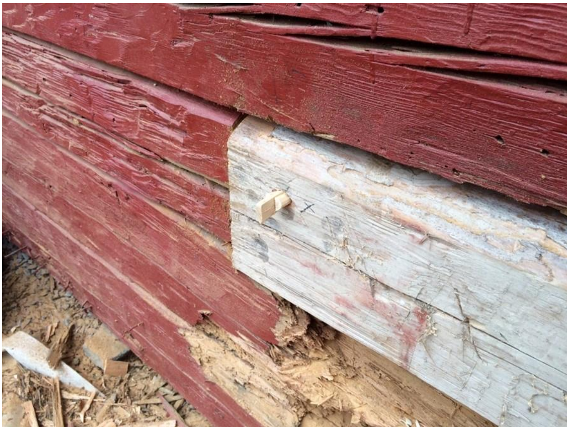
Timret som byts med tekniken halvt i halvt fästes med dymlingar (plugg) och kilar, (helst genomgående dymlingar)
