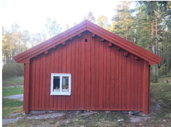
Bildtext: Beroende på vilket tak man väljer kan en vattbräda ska vara utskjuten över vindskivor användas. Antal varv med vindskivor ger olika uttryck för byggnaden. Fler vindskivevarv ger ett mer satt uttryck.
