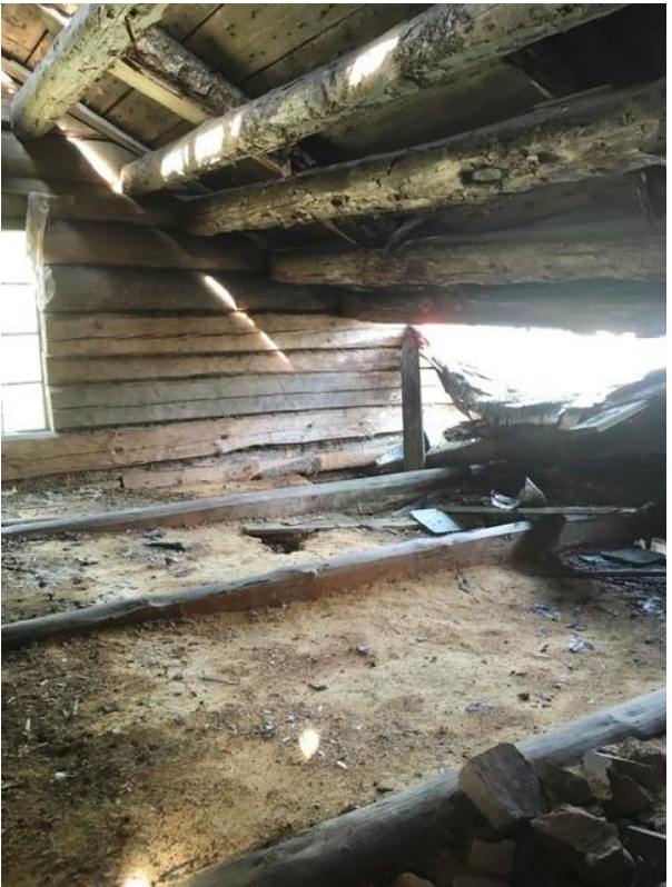
Stora delar av taket är i gott skick när det gäller åsar, rafter och brädor. Taket är delvis öppet i nock och på två ställen nära knutarna men övrigt är det fint.
